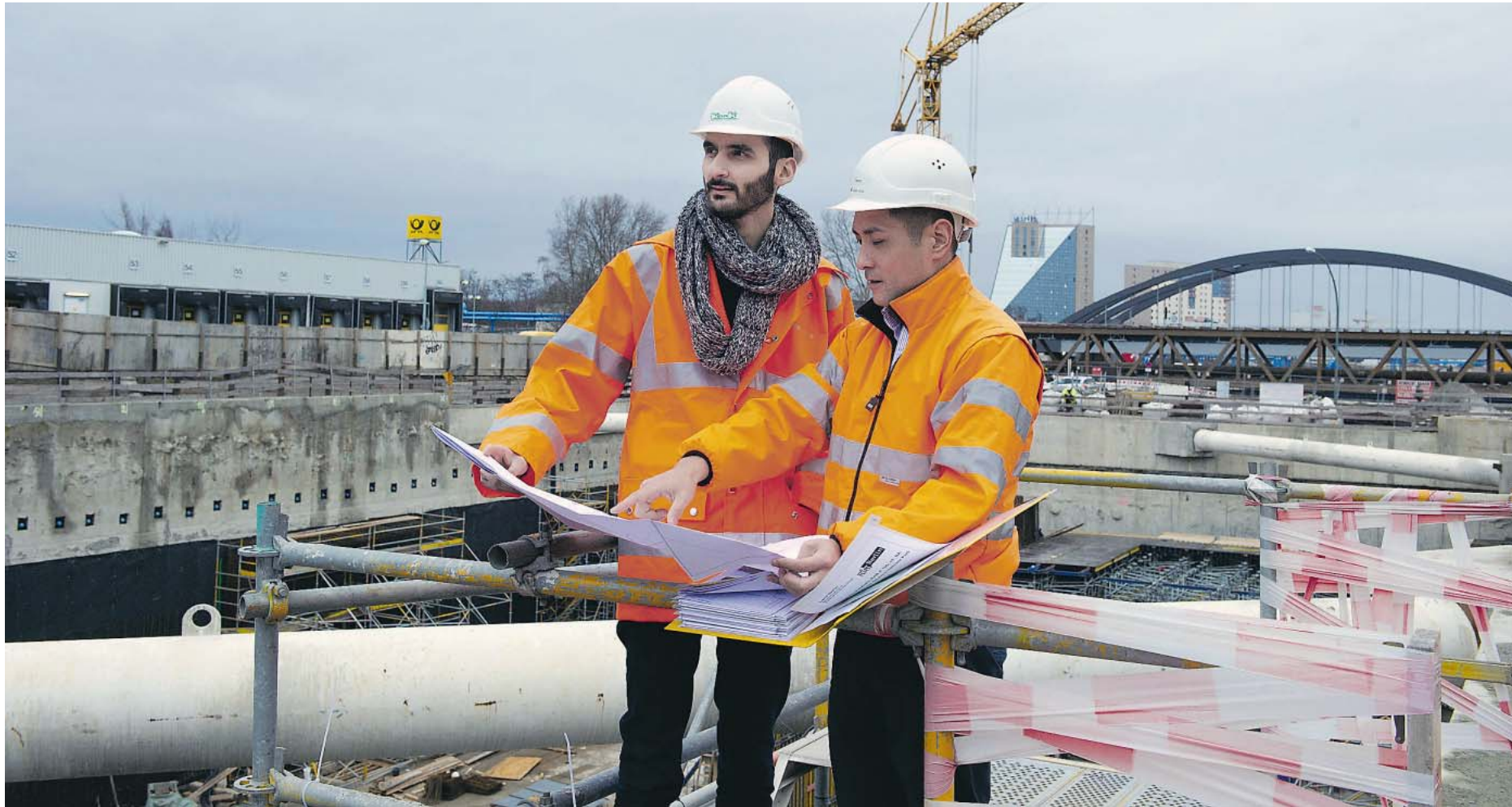
Gemeinsam große Pläne: Modar Rabbat (links) mit seinem Mentor Munkhtuvshin Purevdorj auf der Großbaustelle in Berlin
